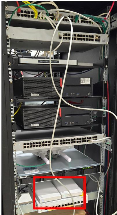
Pour commencer, je branche la borne que je souhaite configurer sur notre switch qui nous sert de banc de test afin de configurer avant de mettre en production.
